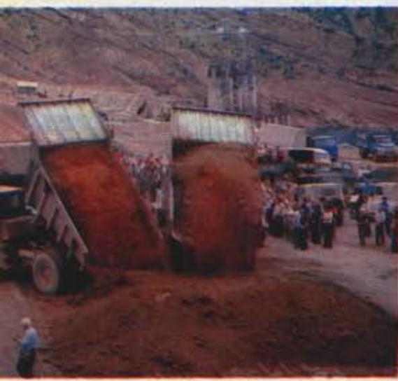
ПОСЛЕДНИЙ КУБОМЕТР СУТЛИНКА В ТЕЛО ПЛОТИНЫ.
